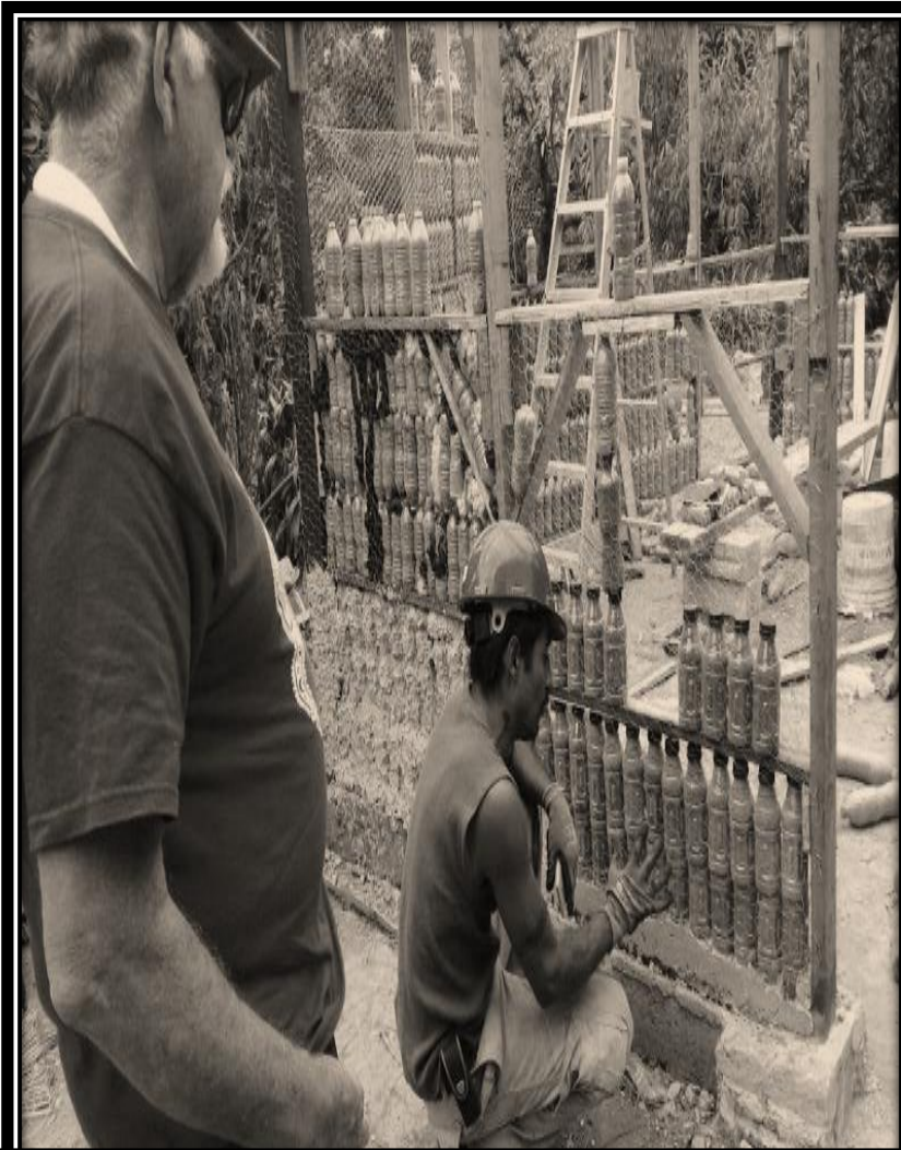
Foto 24. Reconstrucción de vivienda con pet y materiales locales en el Municipio de Ocuilco, Morelos.
